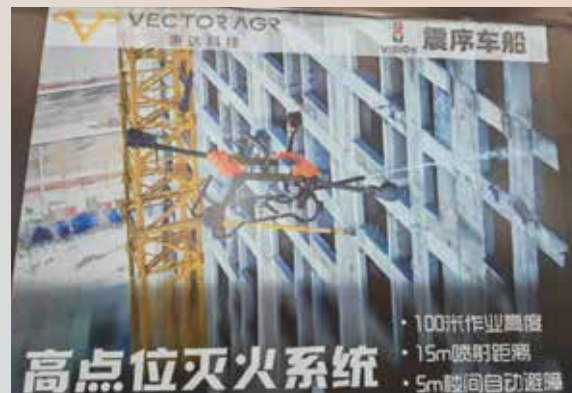
圖 2：高點位滅火系統遙控滅火
